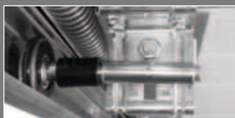
Boční stavitelný pant s ložiskovým kolečkem
